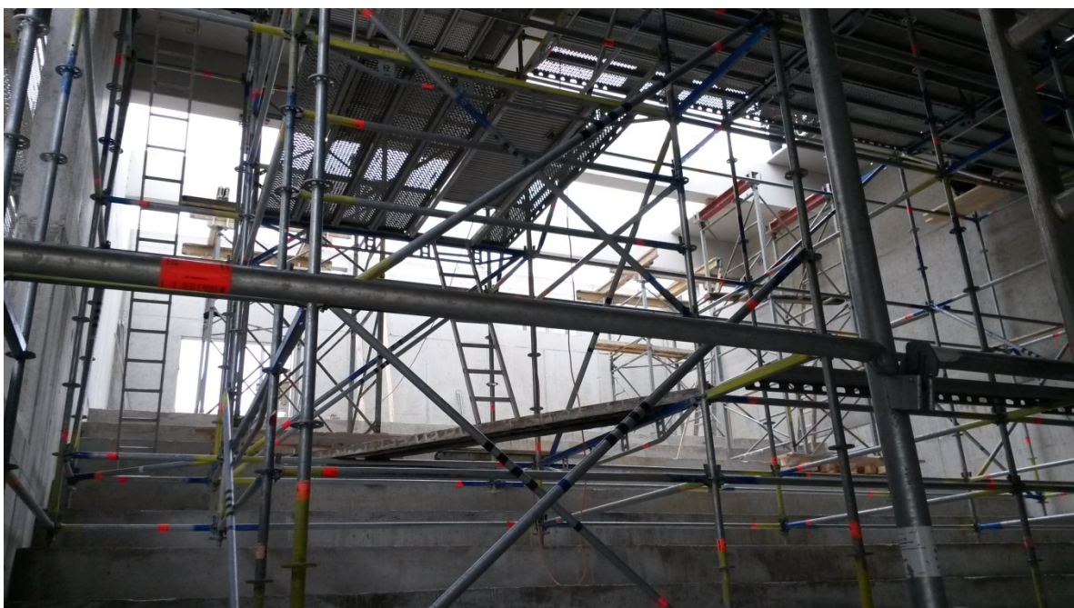
Bild 4 - Raumgerüst im neuen Hörsaal
