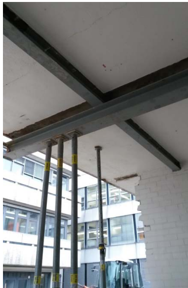
Bild 6 - Deckenunterstützung
