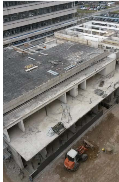
Bild 7 – Nordseite, Deckenabbruch
