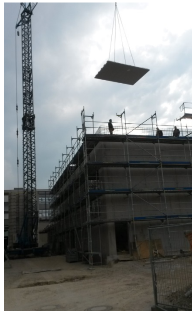
Bild 2- Verlegung FT Platten
